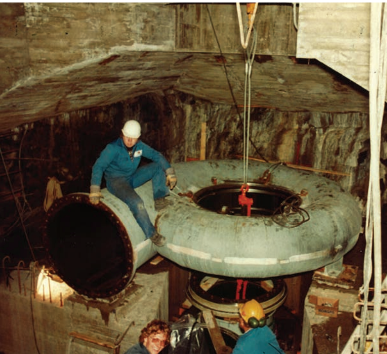
Bygging av Lavka kraftverk, 1981
